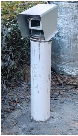
测量仪立柱安装方式
