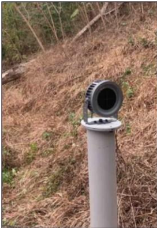
靶标立柱安装方式
