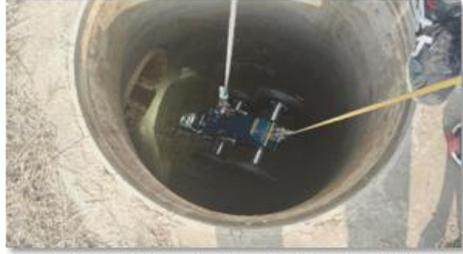
二、打开爬行器灯光，轻拉尾部电缆，使爬行器镜头朝下，缓慢放入井中。
