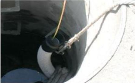
五、下井挂绳绑住护线器，将线器顺电缆放下，滑动到管道口，并固定好挂绳。
