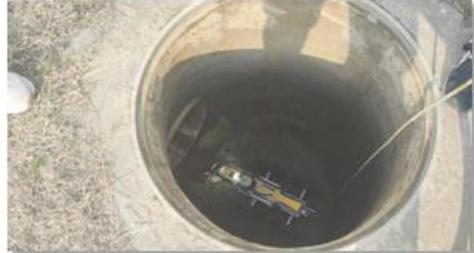
四、将爬行器吊环放平，取下下井挂钩，镜头居中，控制爬行器爬入管中。
