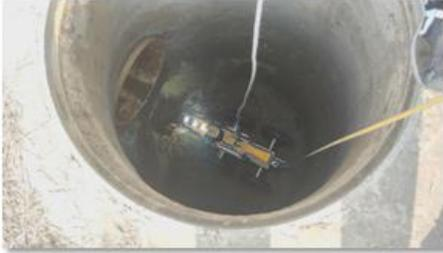
三、快至管道时，保持下井挂绳不动，慢慢待检放松电缆，爬行器姿态恢复平整，拉动电缆调整爬行器方向，对准管道后，缓慢将爬行器送入管道口。
